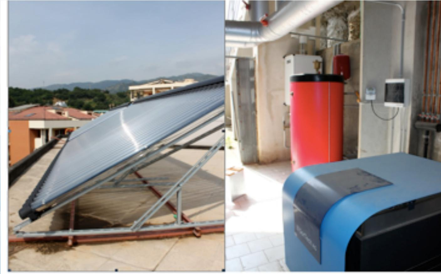
Campo solare a tubi evacuati e chiller ad adsorbimento con accumulo termico (ITAE)
