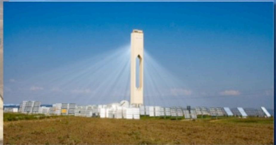
2 centrali gemelle da 11 MW ciascuna con più di 600 eliostati, ubicate nei pressi di Siviglia. L'energia solare è concentrata sulla caldaia della torre dove viene generato vapore che alimenta una turbina Rankine
