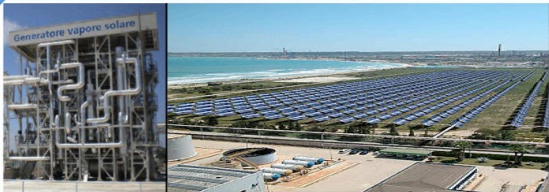
Entrata in funzione nel 2010. 5 MW, 32000 mq superficie riflettente, circuito primario a sali fusi. Produzione di vapore per integrazione di impianto a ciclo combinato alimentato a gas
